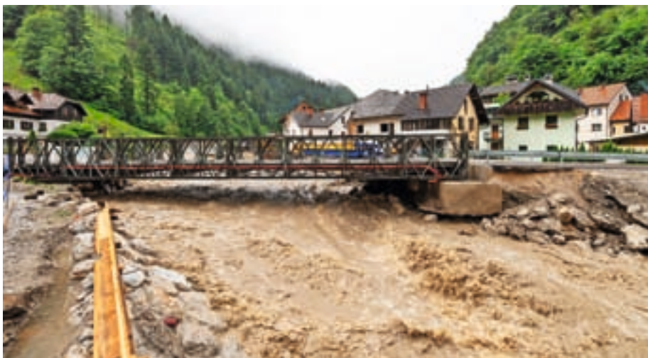
Narasla Selška Sora je spodkopala začasni most v Smolevo, zato so ga morali podbetonirati. / Foto: Simon Benedičič
