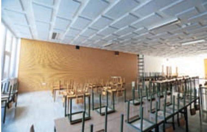
V jedilnici so izvedli akustično oblogo sten in stropa.
